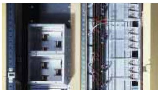
Вспомогательные сборные шины обеспечивают распределение питания вспомогательных устройств, опорного напряжения контрольных цепей, а также некоторых цепей передачи данных. Они расположены в отсеке кабельной сборки по всей полезной высоте ячейки.
